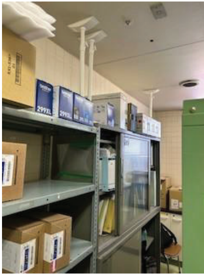
OK 「突っ張り棒」での固定 NG 高所の積載
