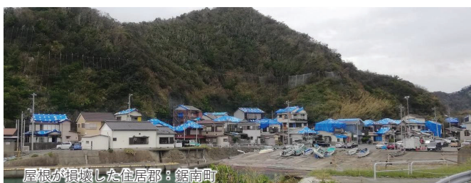
屋根が損壊した住居郡：鋸南町
